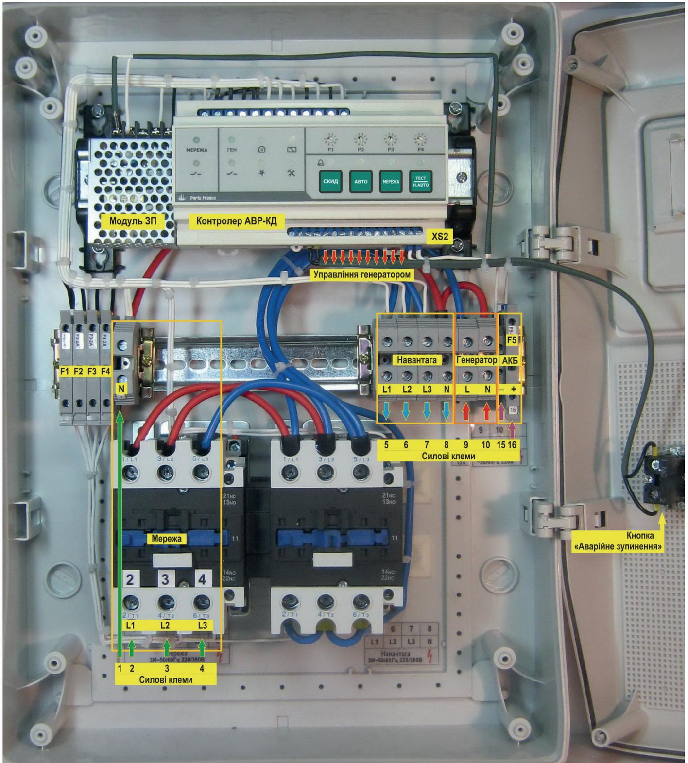
Рис. 6.2 – Внутрішня конструкція і зовнішнє підключення АВР К-65\*
