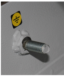
Рисунок 5. Болт заземления.
